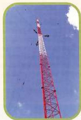
De antenne van WFAN en WCBS.
